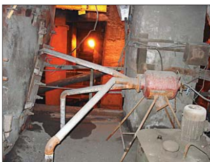
Рис. 4. Установка пневмогенератора на пересыпных течках
