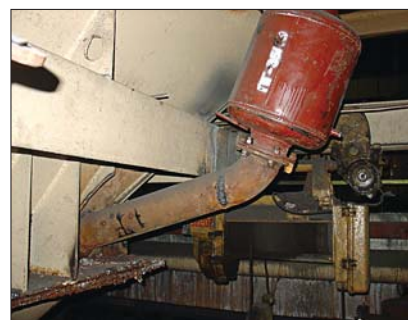
Рис. 3. Установка пневмогенератора на бункере
